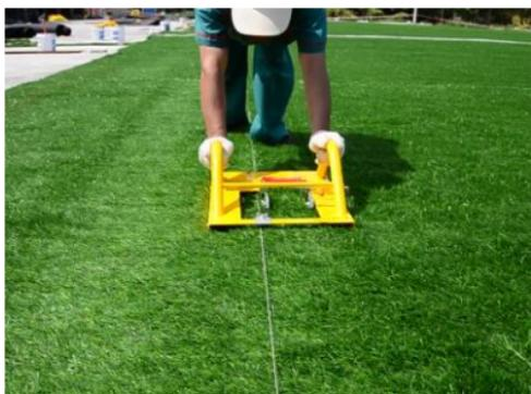
找出步骤1已放好线的位置，使用人造草坪专用施工工具“线型切割器”裁切功能线。
