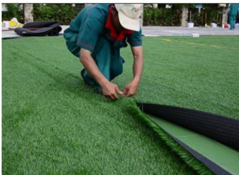
等胶水稍干之后能形成良好的粘接力，然后将两卷草坪边缘覆盖在连接带上，并且压实。
